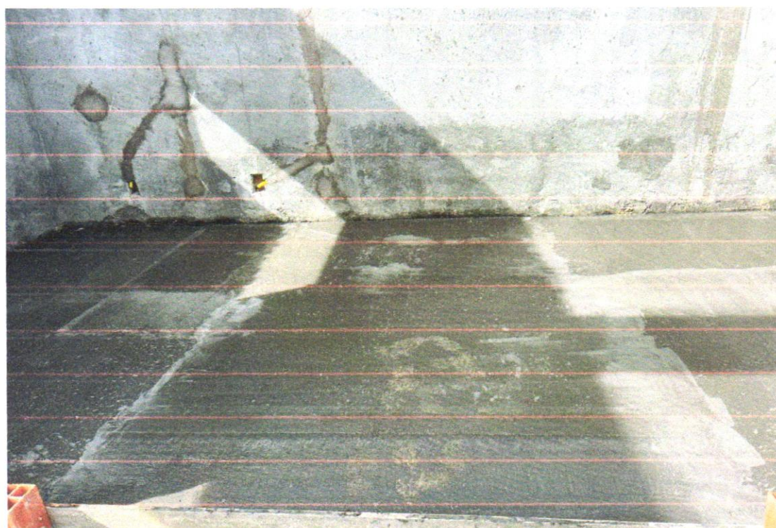
FOTO 18 - IMPERMEABILIZAÇÃO DE PISO COM ARGAMASSA DE CIMENTO E AREIA, COM ADITIVO IMPERMEABILIZANTE, E = 2CM. AF_06/2018
