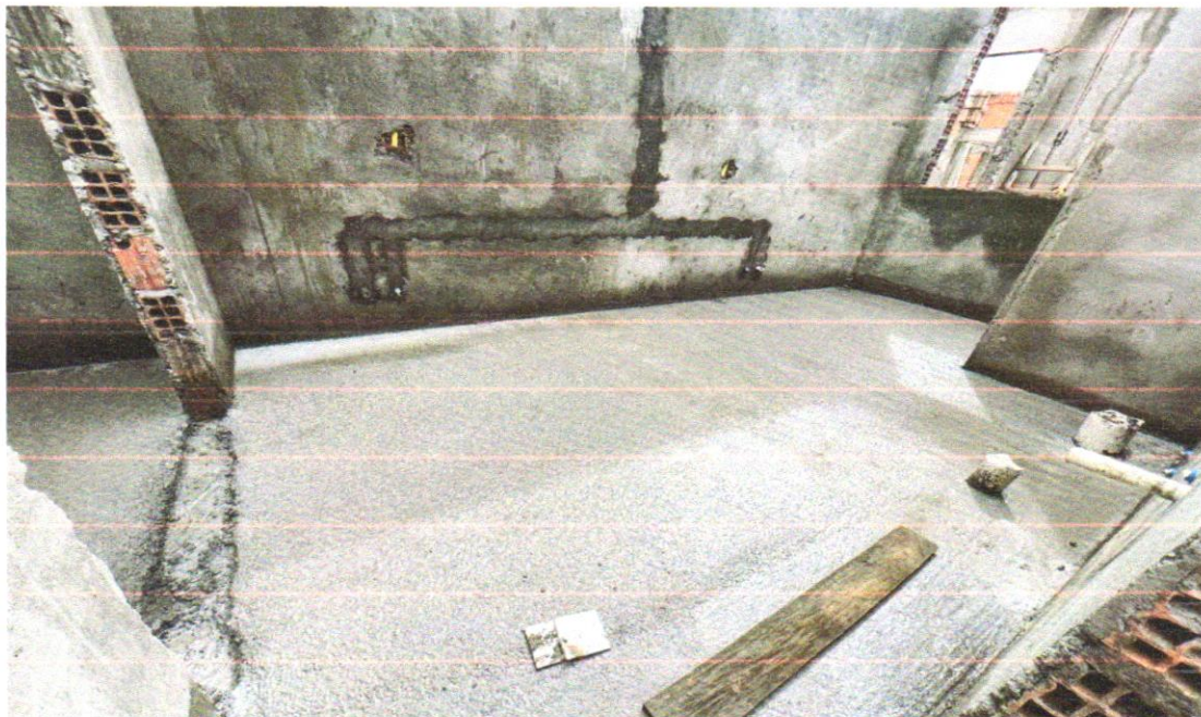
FOTO 18 - IMPERMEABILIZAÇÃO DE PISO COM ARGAMASSA DE CIMENTO E AREIA, COM ADITIVO IMPERMEABILIZANTE, E = 2CM. AF_06/2018
