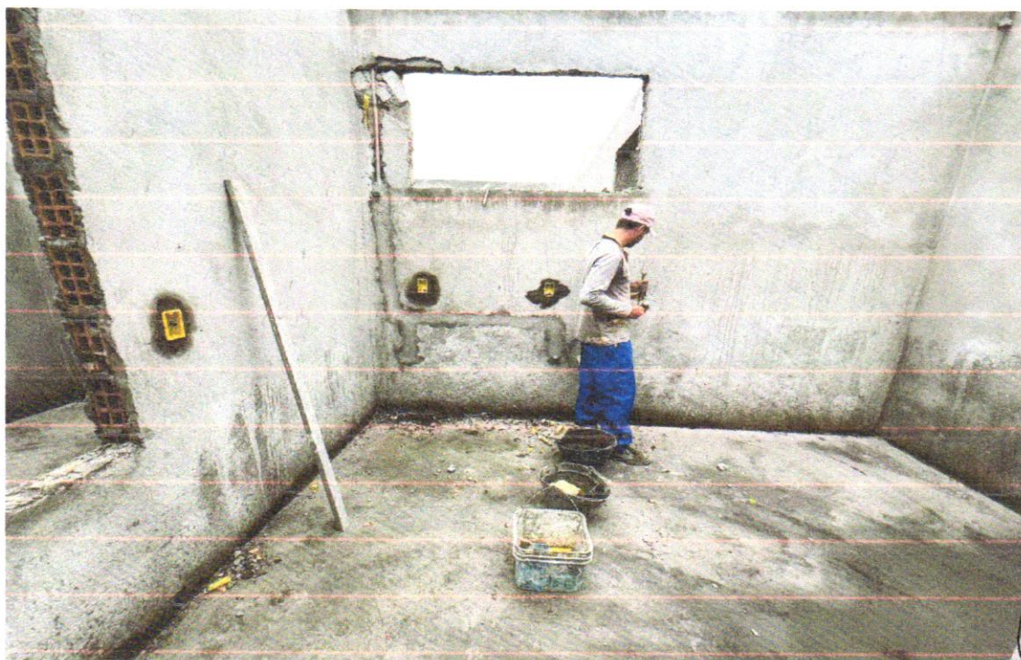
FOTO 46 – Eletroduto PVC flexível 3/4", inclusive conexões
