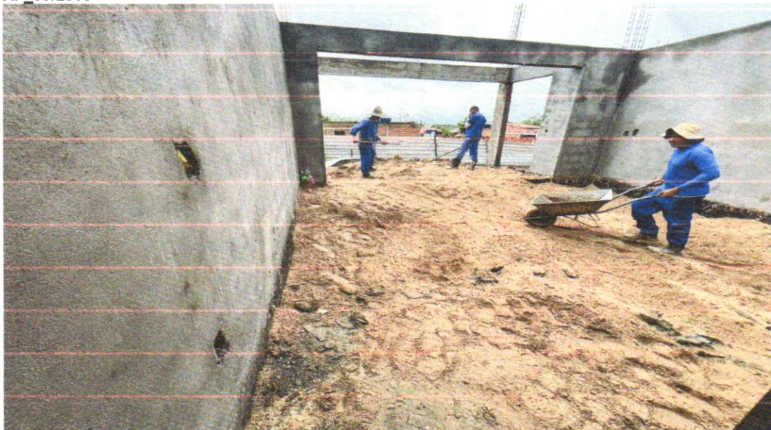
FOTO 02 - ATERRO MANUAL DE VALAS COM SOLO ARGILO-ARENOSO E COMPACTAÇÃO MECANIZADA. AF_05/2016
