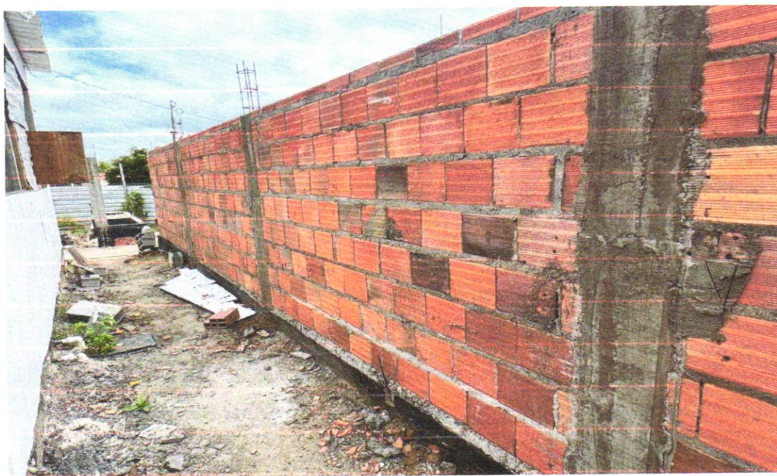
FOTO 10 – Concreto Bombeado fck= 25MPa; incluindo preparo, lançamento e adensamento
