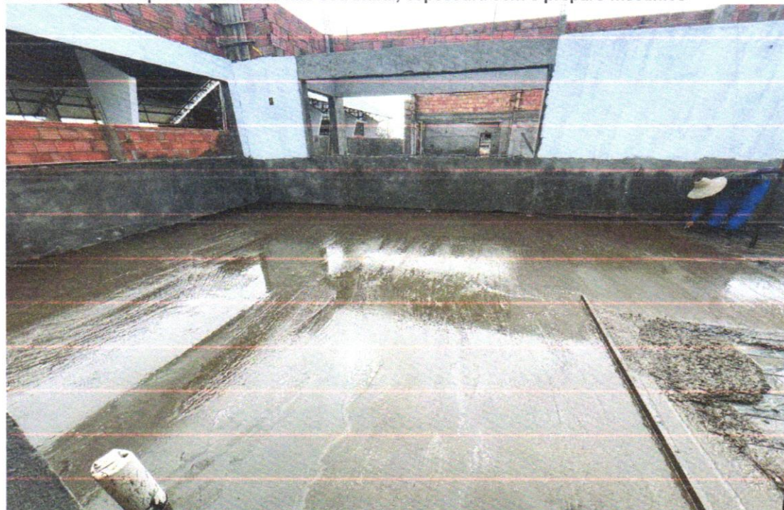
FOTO 50 – Contrapiso de concreto não-estrutural, espessura 3cm e preparo mecânico
