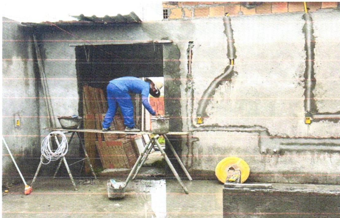
FOTO 46 – Eletroduto PVC flexível 3/4", inclusive conexões
